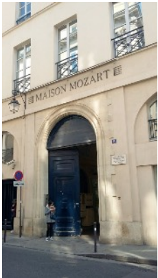
アンナ・マリアさんが亡くなったrue du Sentier 8番地
