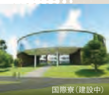
国際寮(建設中)
